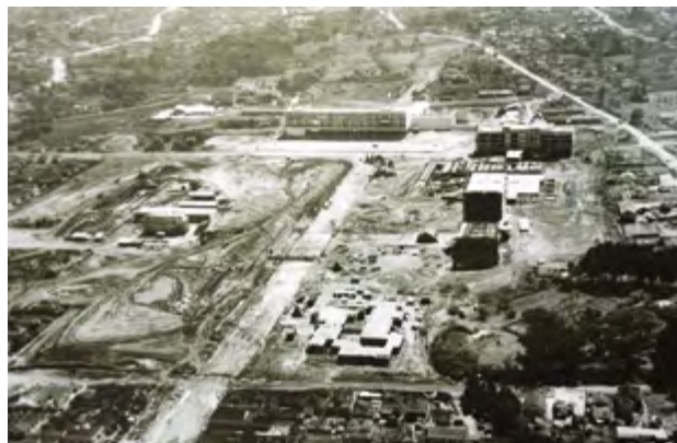
Centro Cívico em construção. Década de 1950.
