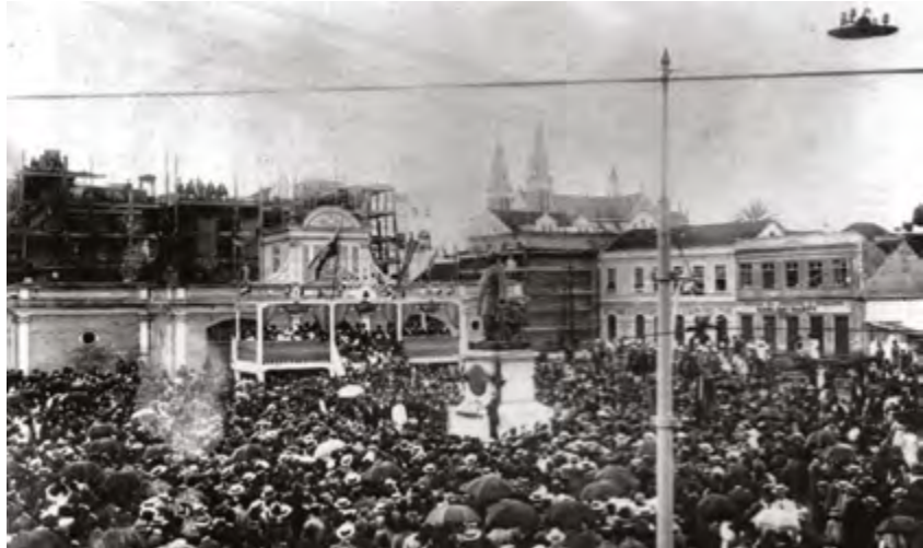
Construção do Paço Municipal. Ainda dentro dos muros do antigo Mercado, no dia da inauguração da estátua do Barão do Rio Branco.
