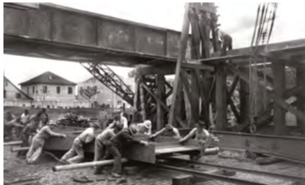
Ponte Preta em construção.
