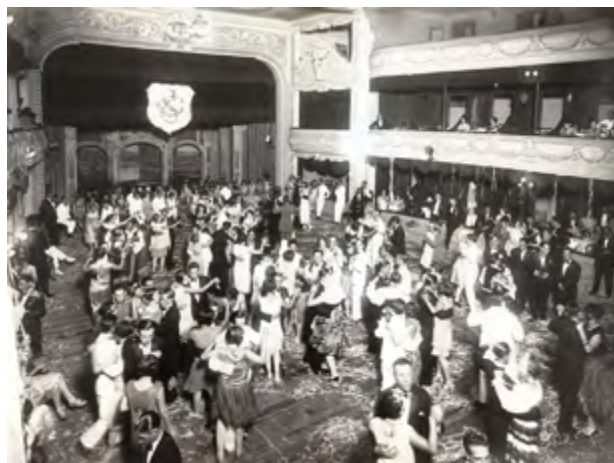
Baile no Salão do Clube Curitibano, ainda na Rua XV.
