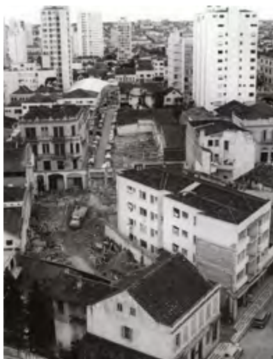
Centro Histórico quando das demolições para alargamento da travessa Nestor de Castro. Foto Sinval Stochero. Casa da Memória.
