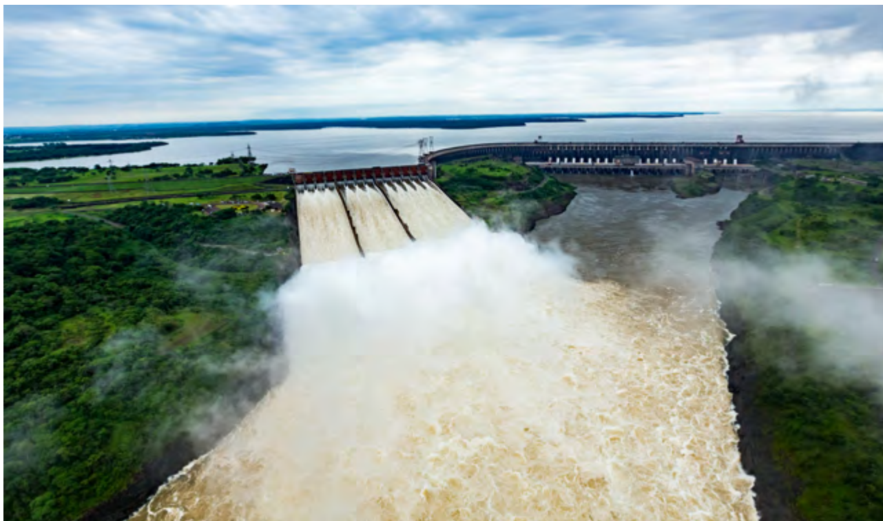
Vista do vertedouro da Usina Binacional de Itaipu - Foz do Iguaçu - PR. Foto de Alexandre Marchetti/Itaipu Binacional.
