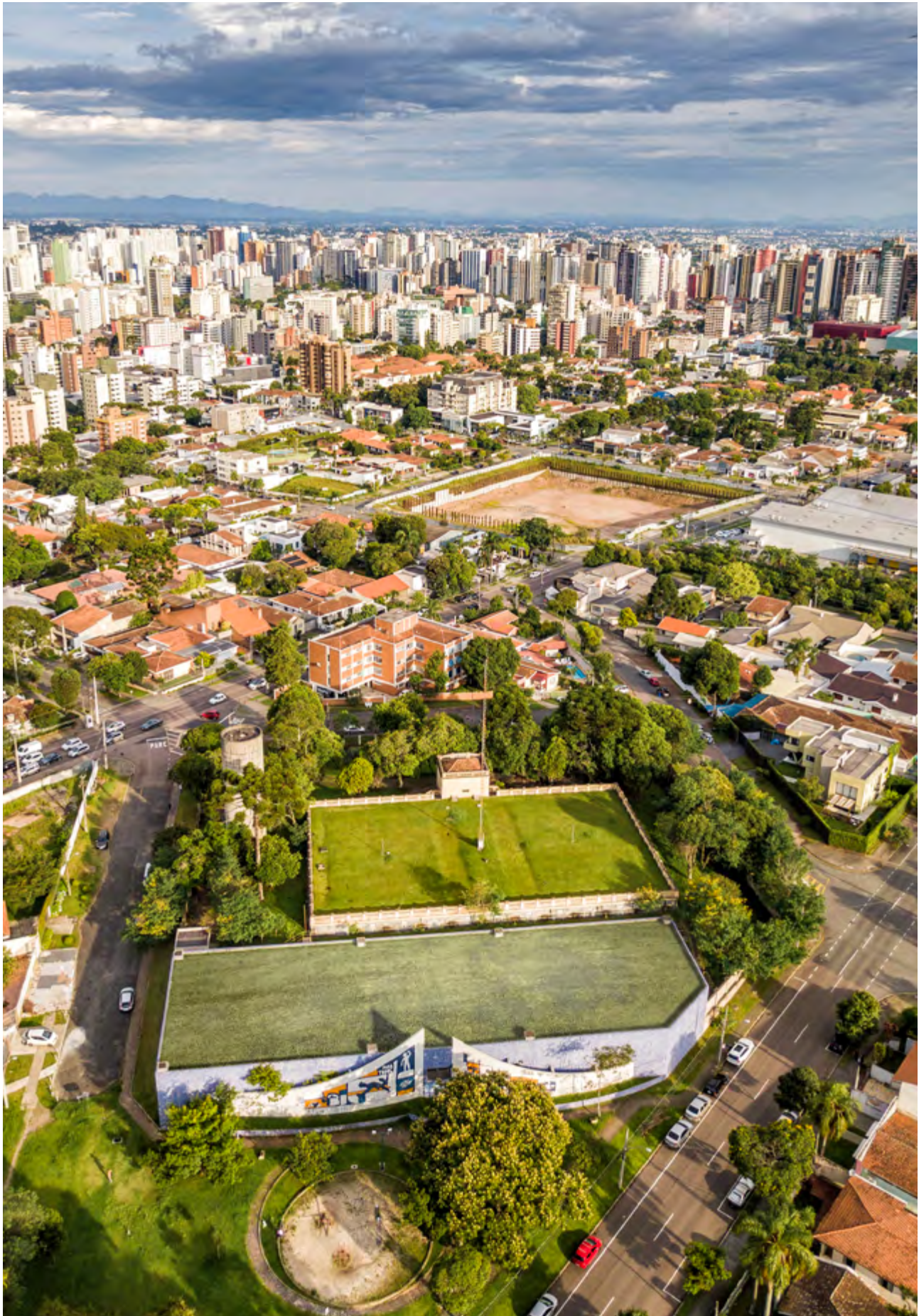
Caixa d'água da Sanepar no Bigorrião, e vista do Batel e setor estrutural de Curitiba.
