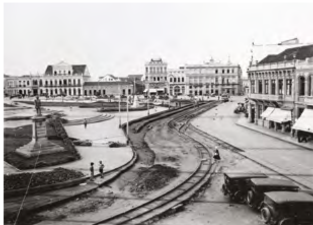
Novos trilhos são instalados na praça Tiradentes.
