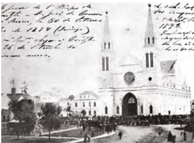
Fotos da Catedral em construção e depois de pronta.
