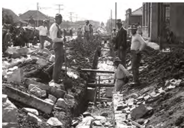
Obra de drenagem e calçamento da Avenida Marechal Floriano Peixoto, 1934. Foto Arthur Wischral.
