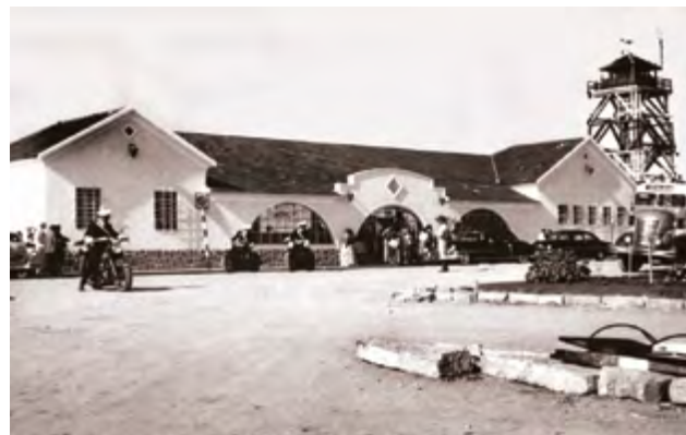
Aeroporto Afonso Pena, primeira estação de passageiros.
