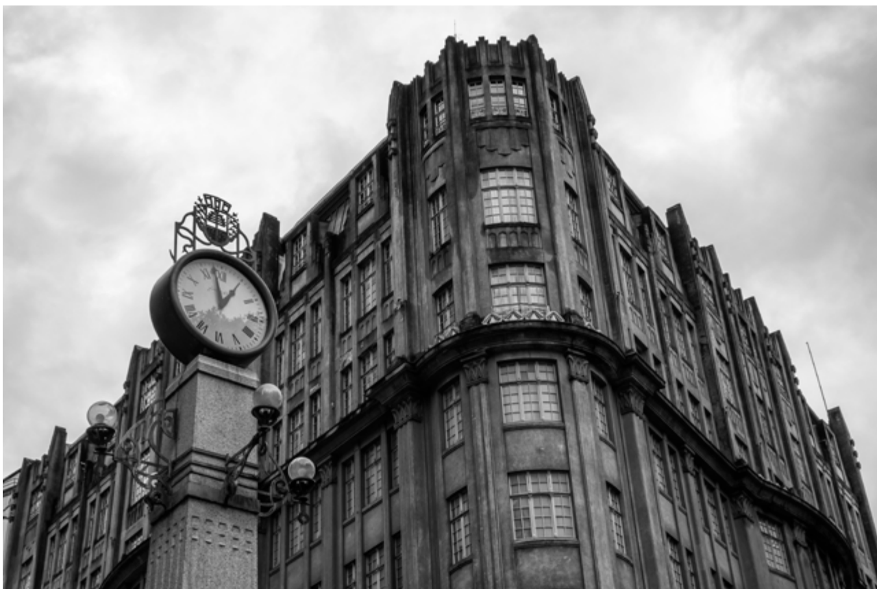
Detalhe da fachada do edifício Garcez em estilo art déco . Foto Valmir Singh.
