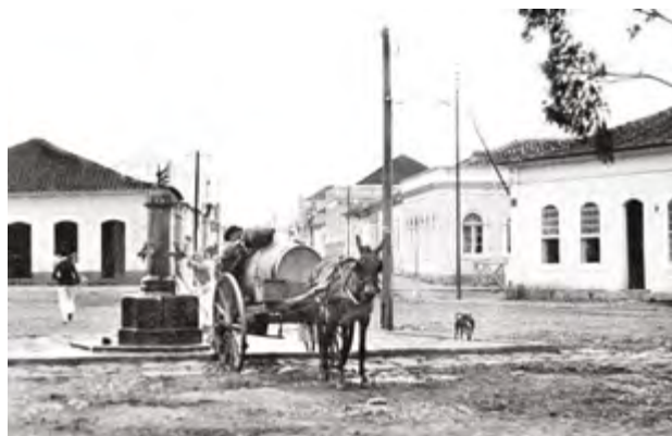
Desde 1871, chafariz na nascente do Largo da Ponte do Ivo, atual praça Zacarias.
