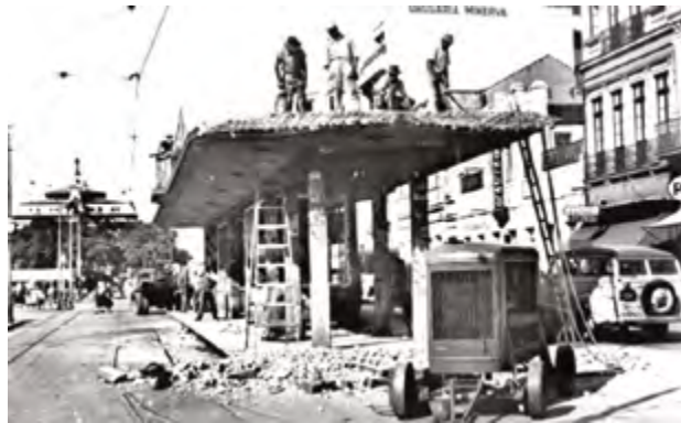
Demolição da estação de bondes para abrir espaço ao trânsito de carros. 1952.
