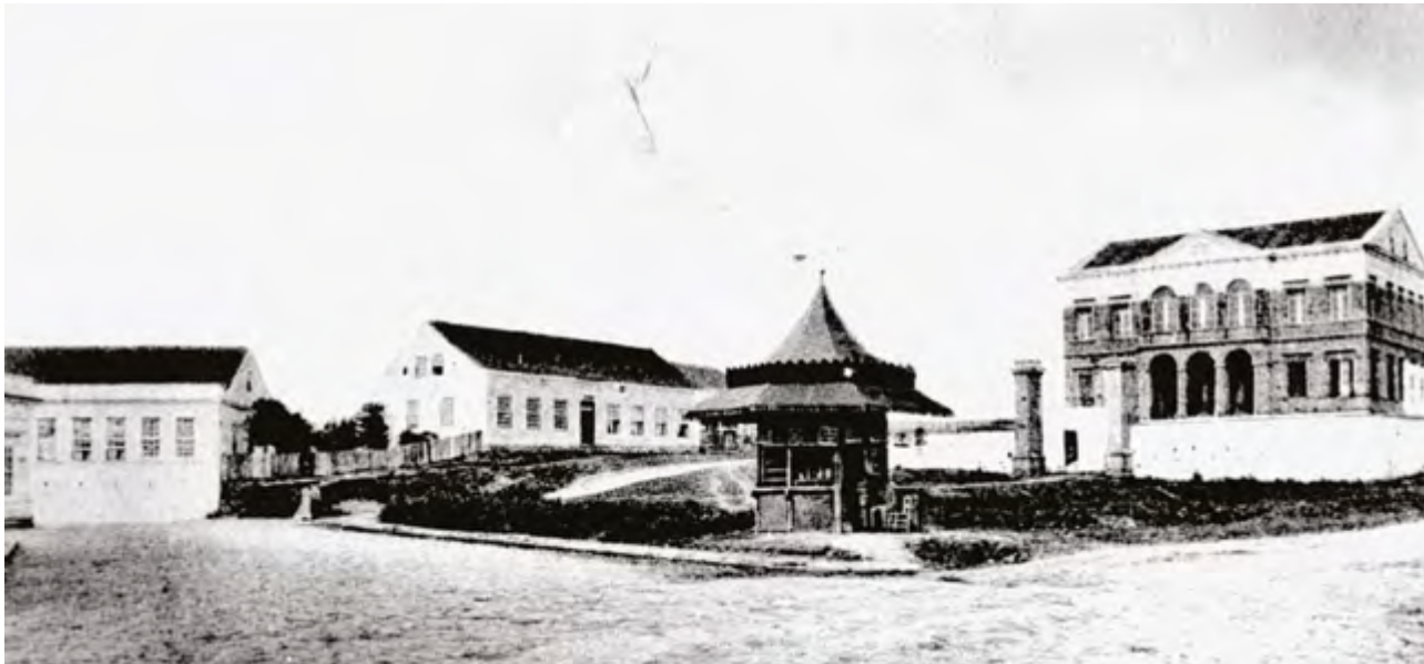
Sociedade Garibaldi em construção, com quiosque do jogo do bicho na praça. Foto Frederico Lange, 1910.
