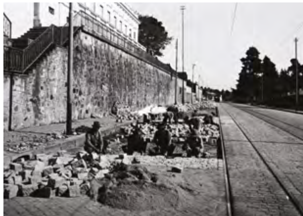
Calçamento da então rua Dr. Pedrosa, hoje Benjamin Lins, no Batel. Vê-se a casa de Manoel de Macedo-Museu Paranaense, já demolida. Foto Arthur Wischral.
