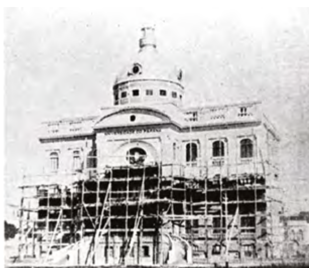
Palácio da Luz em construção.
