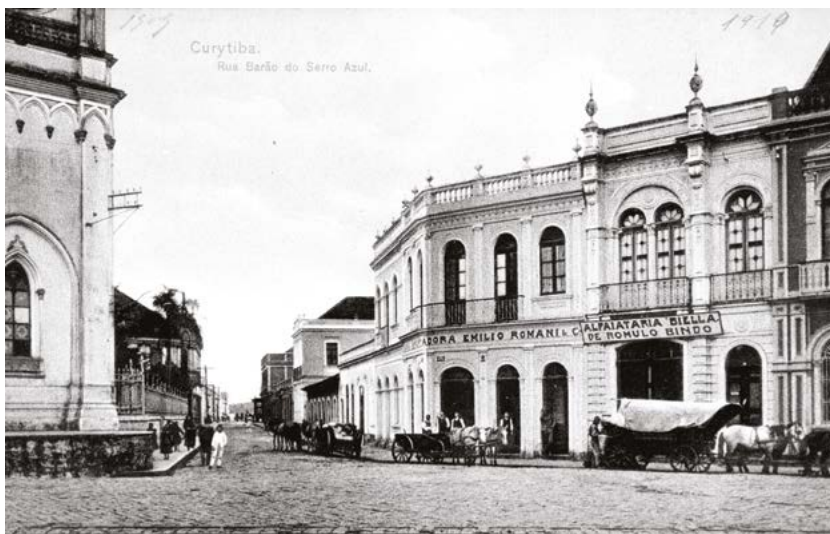
Armazém Emílio Romani e Alfaiataria Biella, de Rômulo Bindo, 1919. Ao lado da Catedral.
