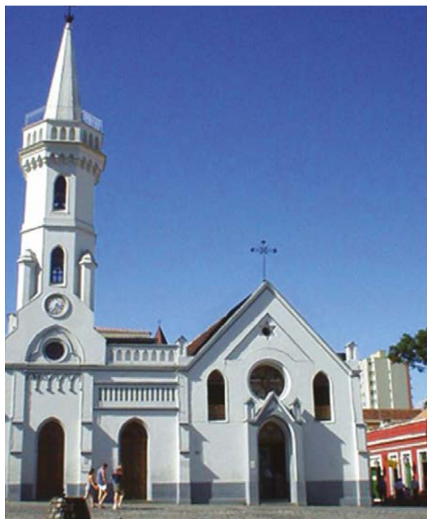
Igreja da Ordem Terceira de São Francisco das Chagas edificada em 1737. A torre foi erguida em 1884.
