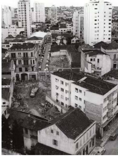
Centro Histórico quando das demolições para alargamento da travessa Nestor de Castro. Foto Sinval Stochero. Casa da Memória.
