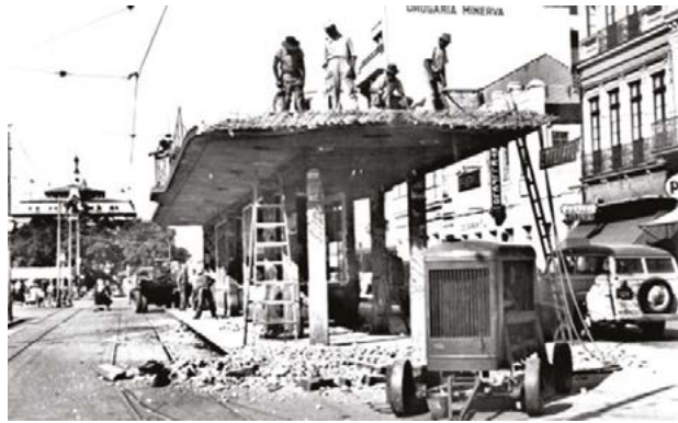
Demolição da estação de bondes para abrir espaço ao trânsito de carros. 1952.
