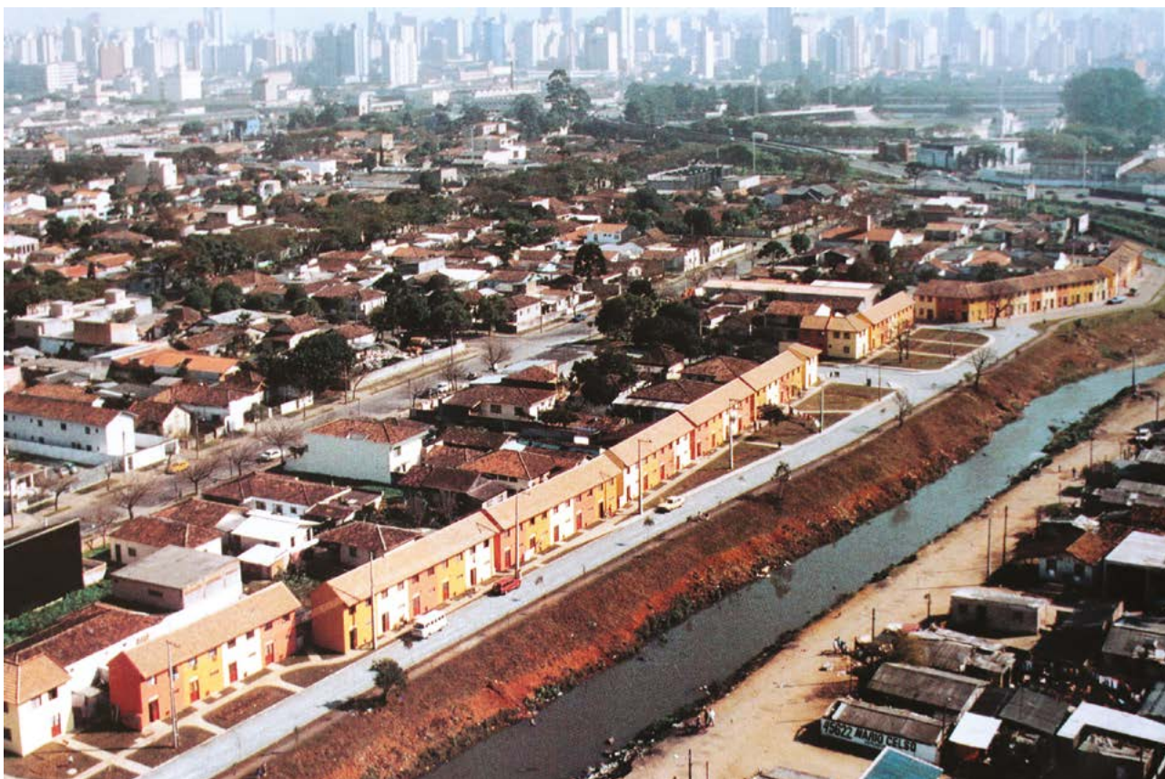
Primeira Vila de Oficinas de Curitiba (1993), junto ao rio Belém.
