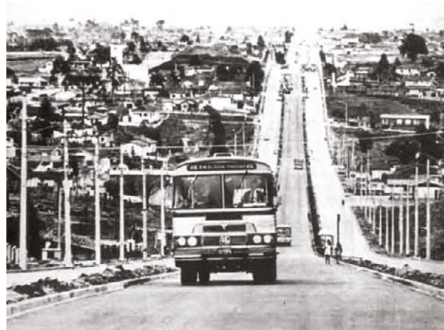
O prefeito Ivo Arzua abriu a avenida Paraná e ampliou a avenida Kennedy, então avenida Guáira.
