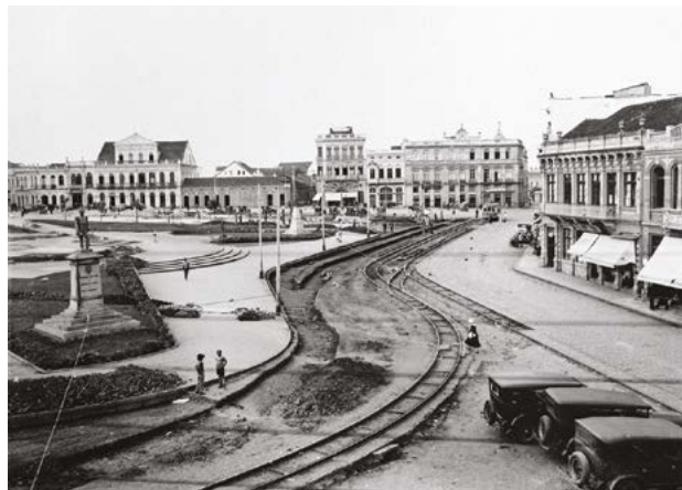
Novos trilhos são instalados na praça Tiradentes.
