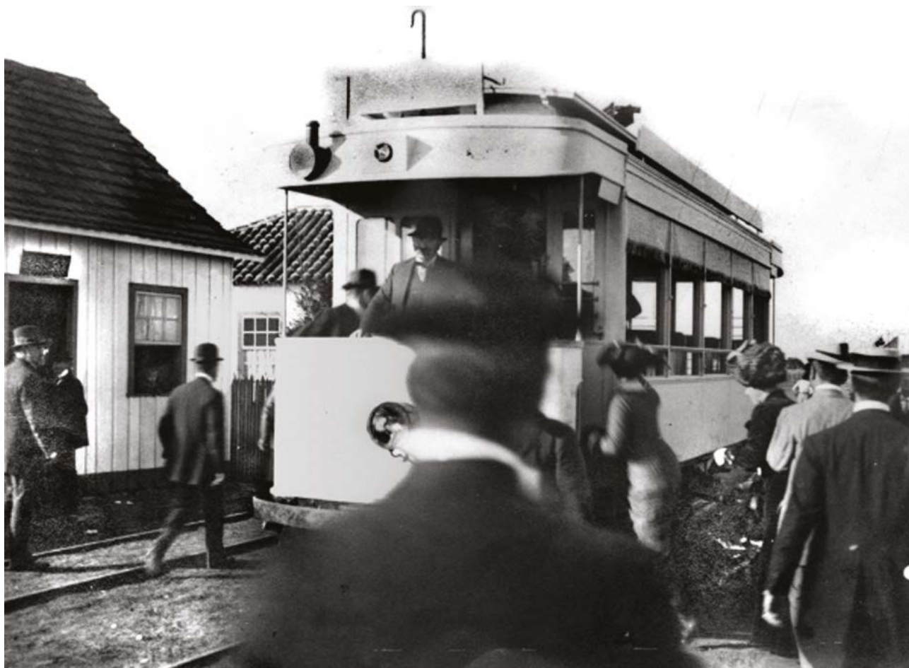
Em janeiro de 1913 começaram a circular em Curitiba os bondes elétricos.
