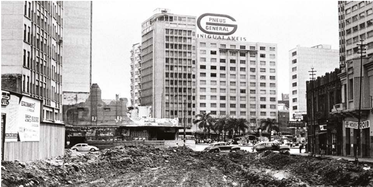
O alargamento da avenida Marechal Deodoro provoca a demolição do Cine Luz
