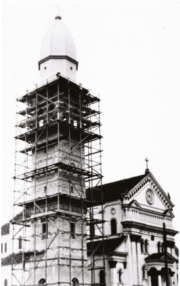
Umbará: Construção da torre da Matriz de São Pedro, 1950. Obra de João de Mío.
