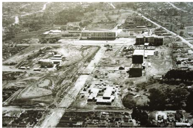
Centro Cívico em construção. Década de 1950.
