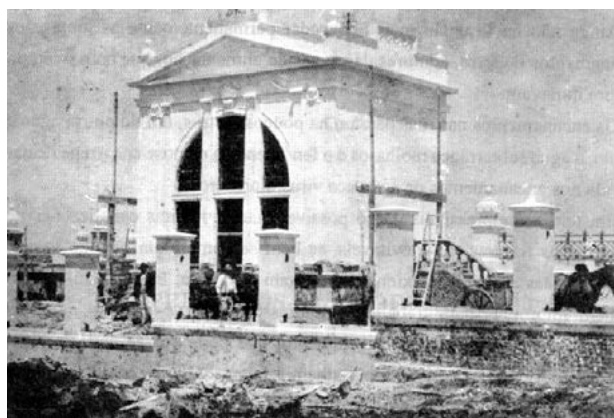
Reservatório do Alto de São Francisco em obras. Foto de 1909.
