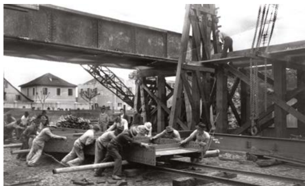
Ponte Preta em construção.
